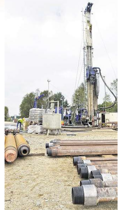
Fachleute vermuten unter dem Weißenstädter Becken in 1500 Meter Tiefe Thermalwasser: Am Dienstag hatte sich der Bohrer bis auf 220 Meter durchgefressen. Foto: Miedl
