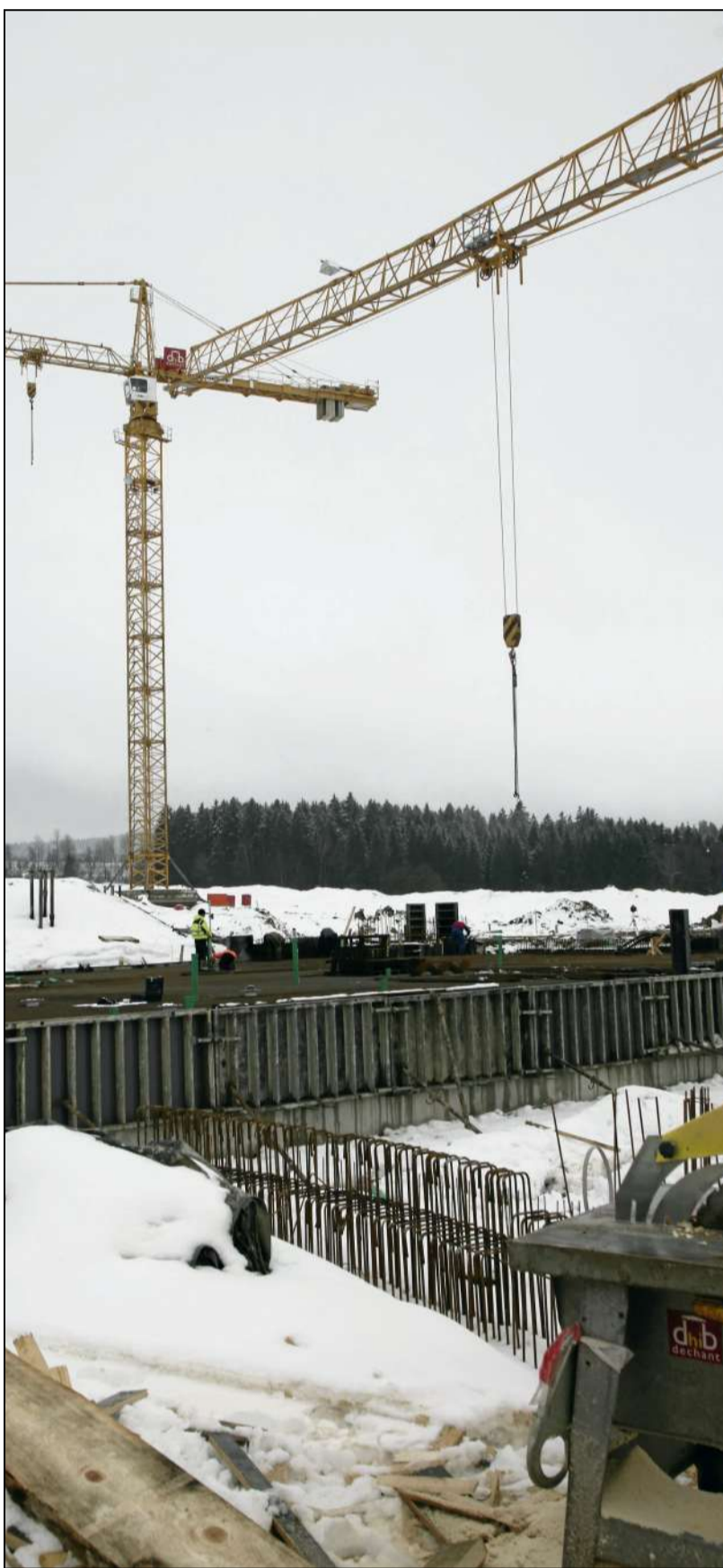
Hier entsteht gerade das Untergeschoss des neuen Kurzentrums in Weißenstadt. Eröffnung soll Oktober 2016 sein. Foto: Lapp
